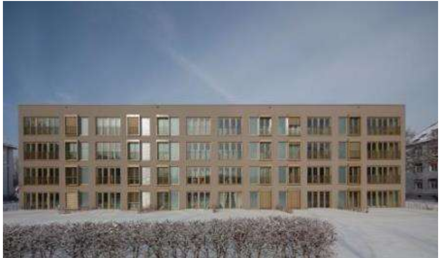
Südansicht mit großen Fensterflächen und verglasten Loggien (Foto: Michael Heinrich, München)
