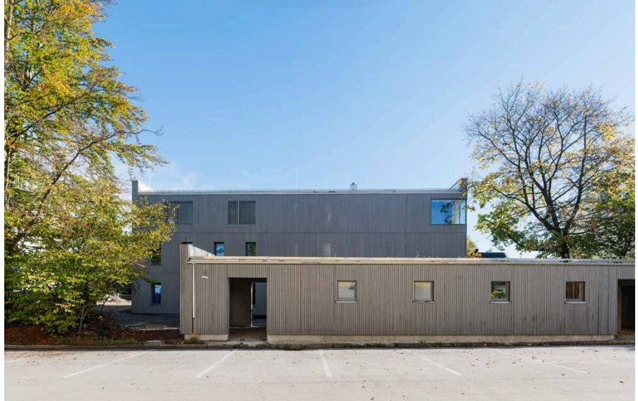
Ansicht Nord mit Nebengebäude
